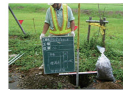
土質調査 ▶ CBR調査 ▶ 路床調査
