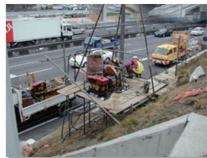
地質調査 ▶ 土質及び岩壁ボーリング調査 ▶ サウンディング調査
